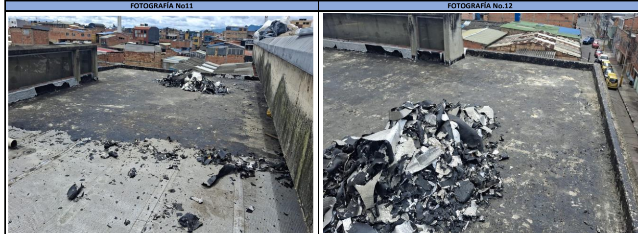
RETIRO MANTO ASFALTICO EN CUBIERTA ZONA BAJA
